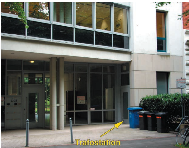
Trafostation architektonisch in die Fassade integriert
